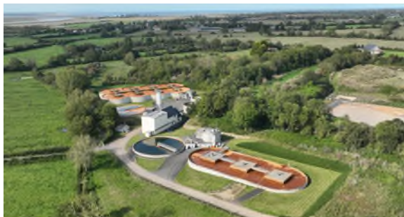
Figure 45 : Station d'épuration du site d'Isigny Sainte-Mère
