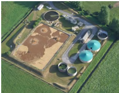
Figure 47 : Station d'épuration « La Capipontaine » sur la commune de Chef-du-Pont
